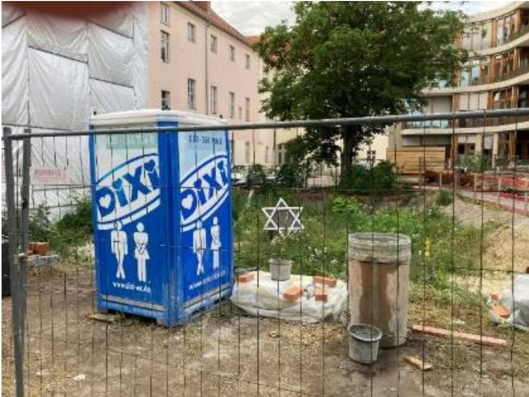
Baustelle Schlossstraße 1 in Potsdam, Juli 2021 – Hier wird die Schein-Synagoge gebaut Foto: Gesetzestreue Jüdische Landesgemeinde Brandenburg
